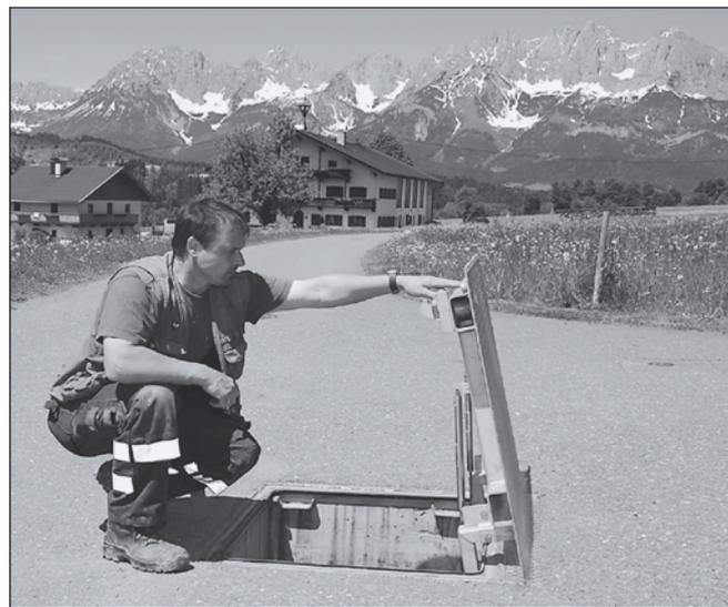
*Stadtwerke-Mitarbeiter Josef Resch beim Schacht im Bereich Steinerbach, von dem aus die Wasserversorgung von Oberndorf mit Kitzbüheler Wasser geregelt werden kann. Im Bild rechts ist die Wasserleitung mit angeschlossenem Zähler erkennbar.*
