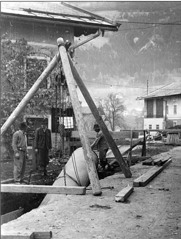
*Graggaugasse, Versenkung riesiger Kanalrohre mittels einfachen Flaschenzugs.*
